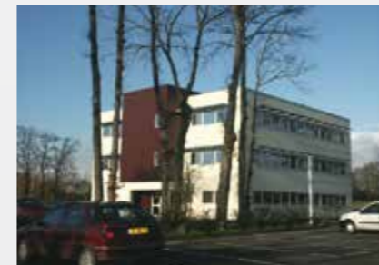
Parc de Lormandières - 6 000 m 2 de bureaux - Bruz-Kerlann (35)
